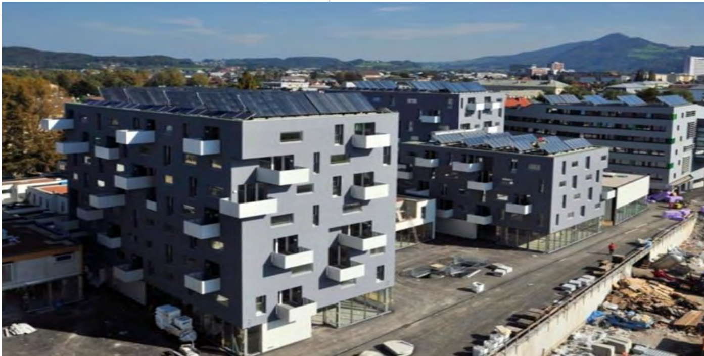
Solar district heating Stadtteil Lehen in Salzburg
